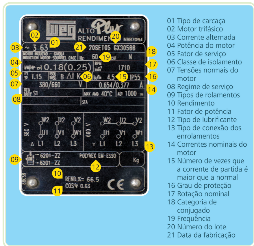
Figura 1.7: Dados de placa de um motor trifásico Fonte: CTISM
