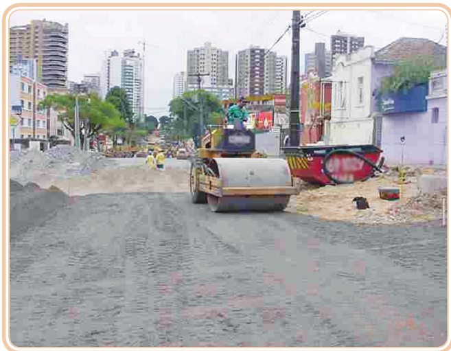
Figura 4.4: Concreto compactado a rolo
