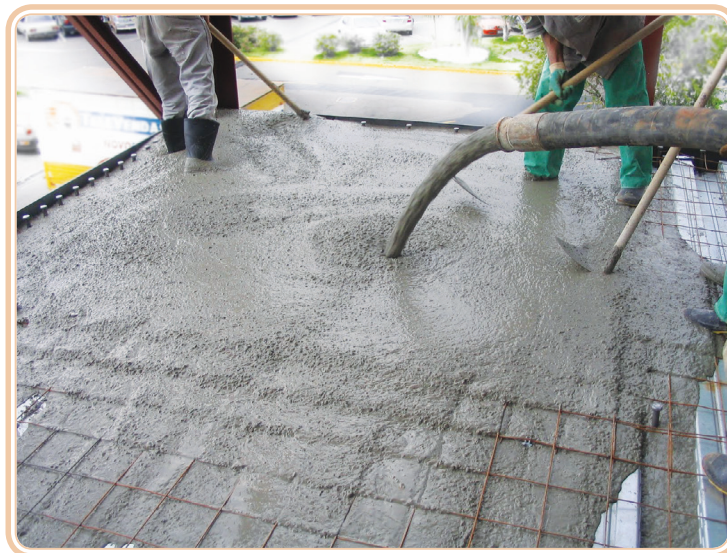
Figura 4.8: Lançamento de concreto por bombas
