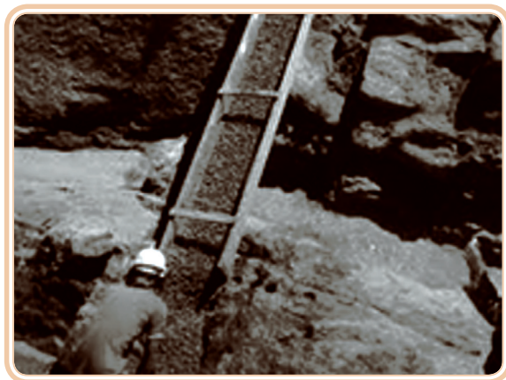
Figura 4.6: Lançamento de concreto por calhas
