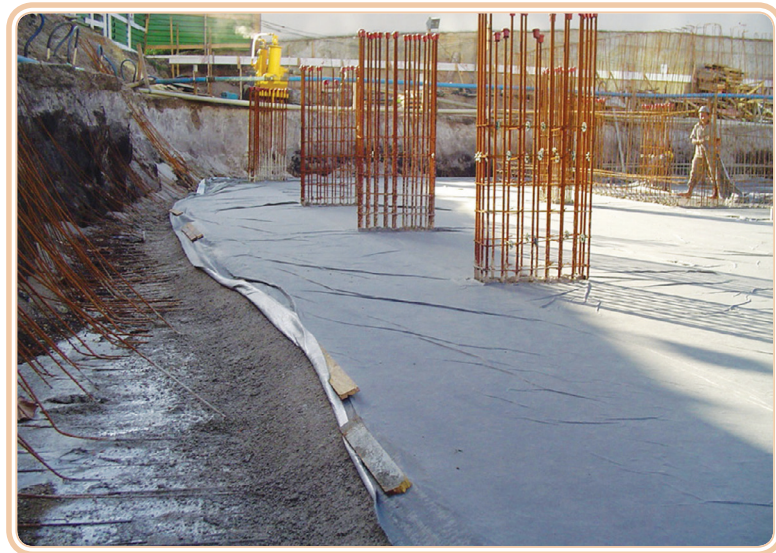
Figura 4.10: Cura do concreto por recobrimento da estrutura
