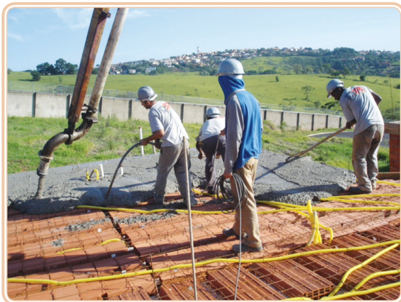
Figura 4.9: Vibrador de imersão (de agulha)
